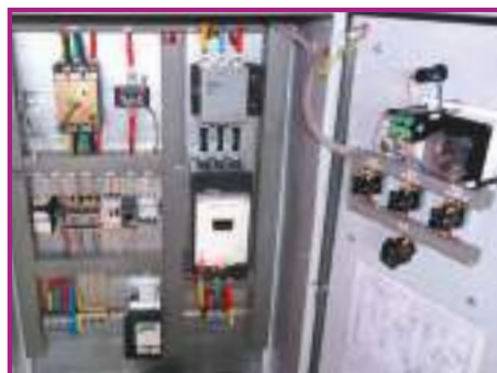
Шкаф управления с частотным преобразователем
