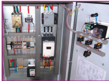
Шкаф управления с частотным преобразователем
