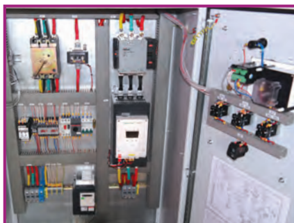
Шкаф управления с частотным преобразователем
