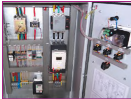
کابین کنترل به همراه مبدل فرکانس
